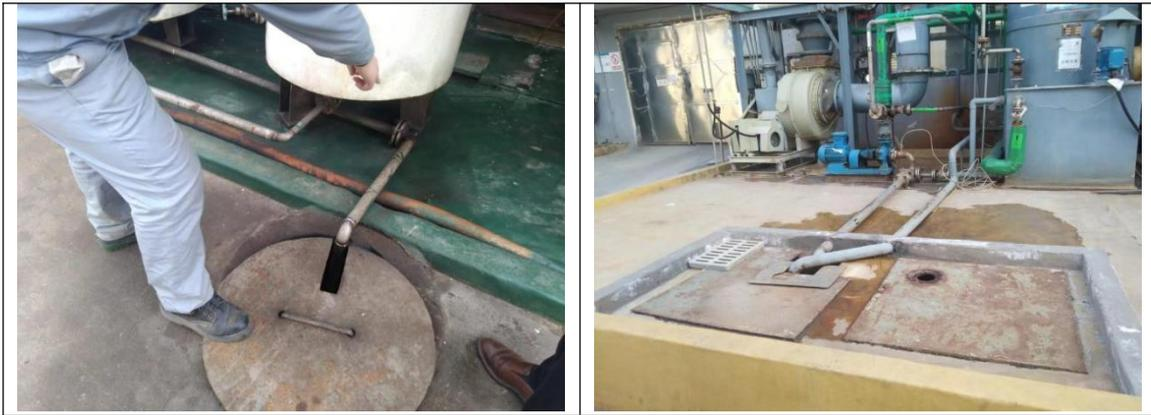
循环水回用，水泵在使用时可能存在润滑油跑冒滴漏的情况，注意日常巡查
